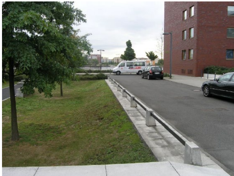
Figur 10: Exempel på en torrdamm i anslutning till en väg. Foto: WRS, 2022
