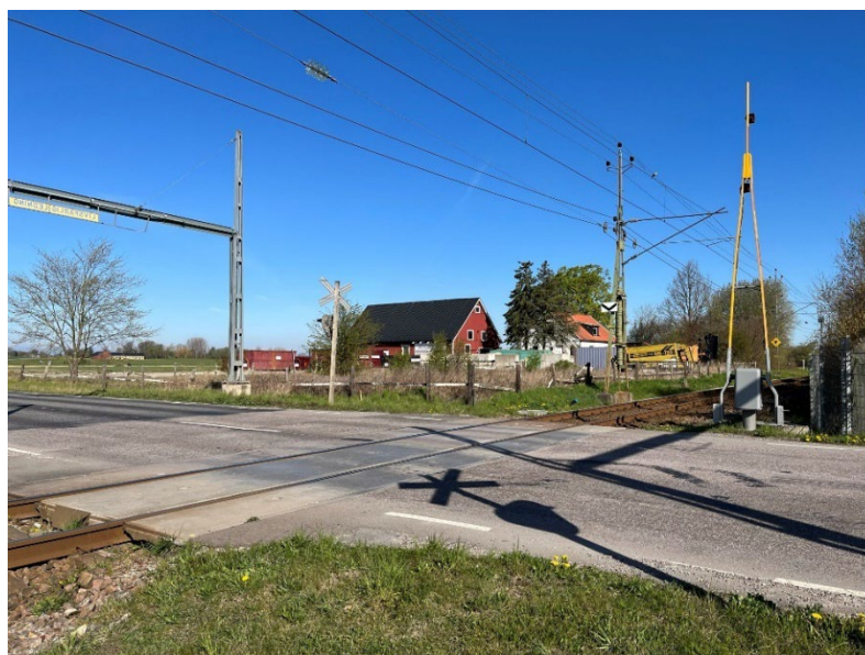
Figur 2: Bild på platsen där Lommabanan korsar väg 913 idag. För att öka trafiksäkerheten bygger Trafikverket om den befintliga plankorsningen om till en planskild korsning likt den som byggdes intill Lomma station på Vinstorpsvägen.
