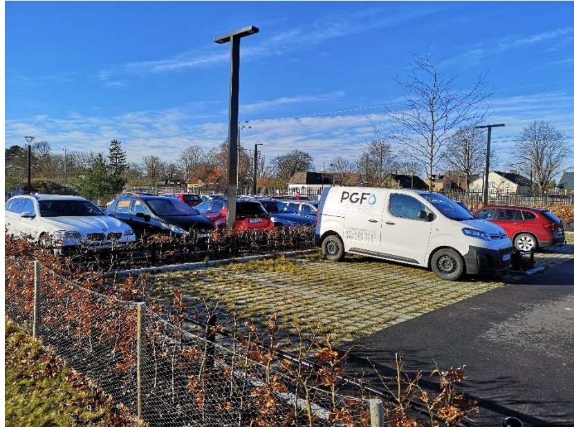
Figur 11: Genomsläpplig beläggning på Lomma station.
