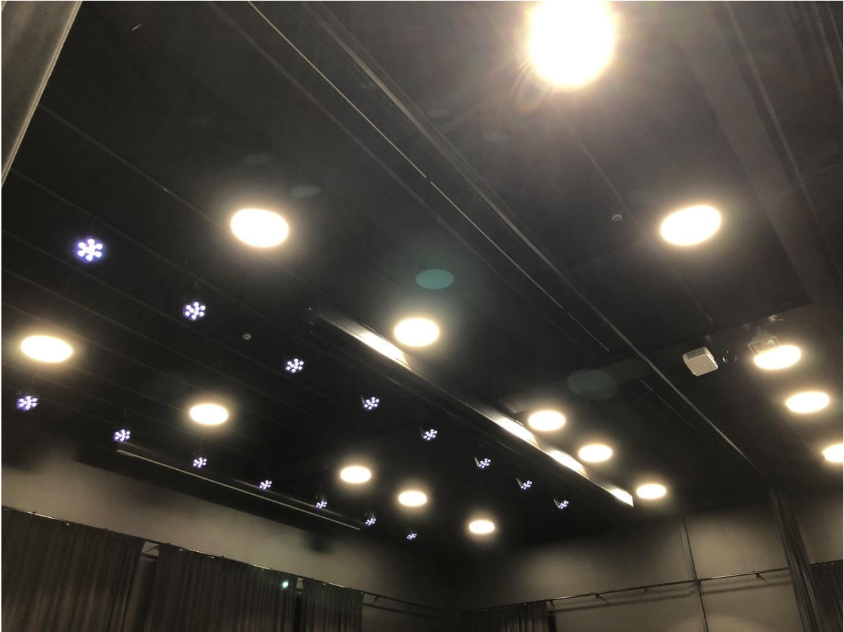
Tak ovan scen. Rår, scenljus, allmänljus, konferensprojektor, konferensduk, bioduk samt el-uttag i kabelränna
