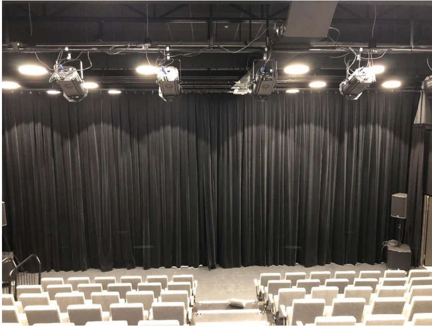
Ridå, sedd från teknikrum
