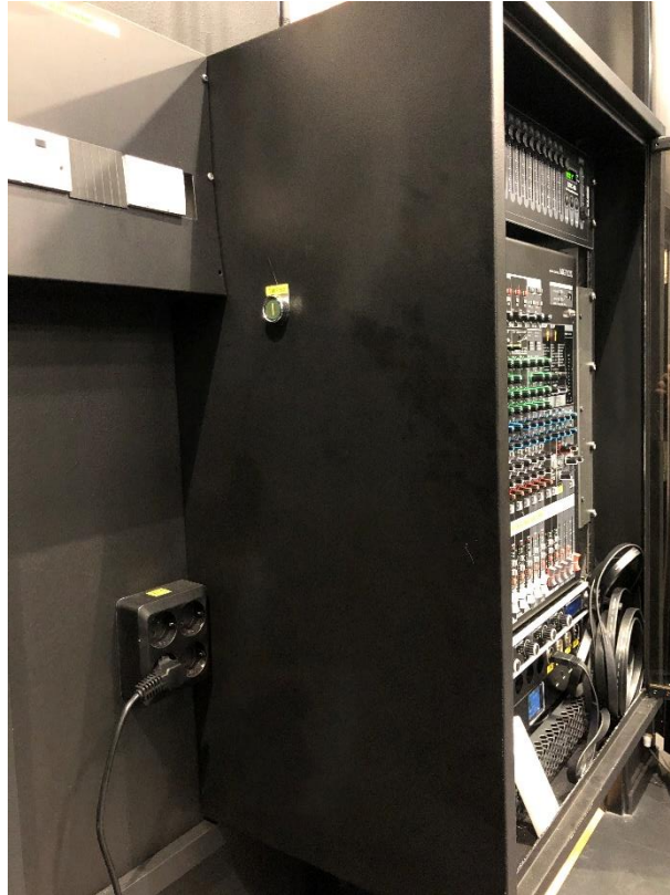
Grön knapp på sidan om tekniksåpet startar/stänger anläggningen
