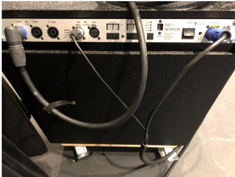
PA-högtalare med sub, vänster
