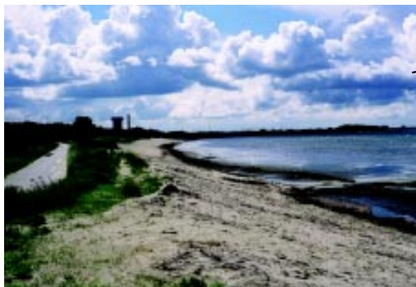
Gabioner täckta med sand ger ett "osynligt" erosionskydd
