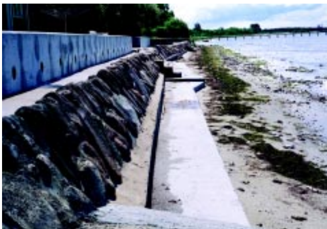
Fig. 12. Mur av sten och betong.
