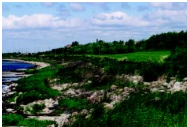
Fig. 19. Exempel på erosionsskydd av sten.
