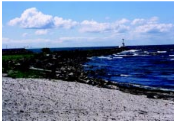
Erosionsskydd av sprängsten.
