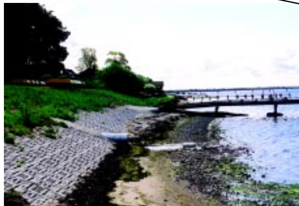
Erosionsskydd av flexplattor, btg.
