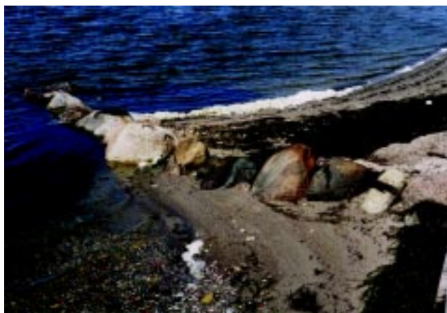
Fig. 25. Exempel på ”mini hövd” och dess effekt.
