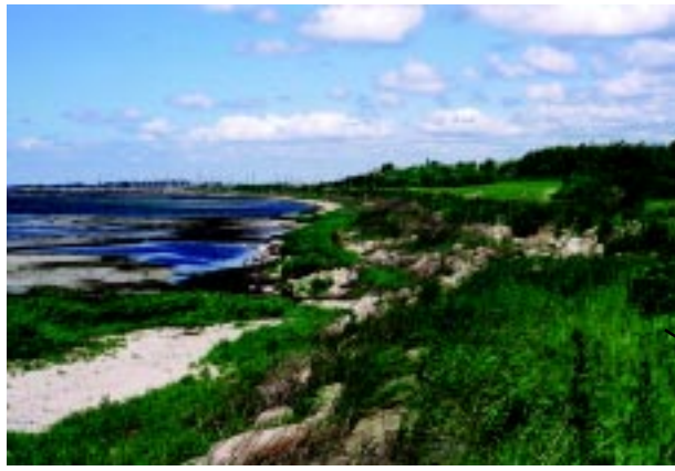
Strandbrinken är skyddad med kullersten.
