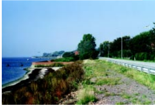
Gabioner som är väl överväxta
