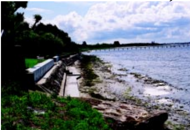
Privat skydd av platsgjutet betong
