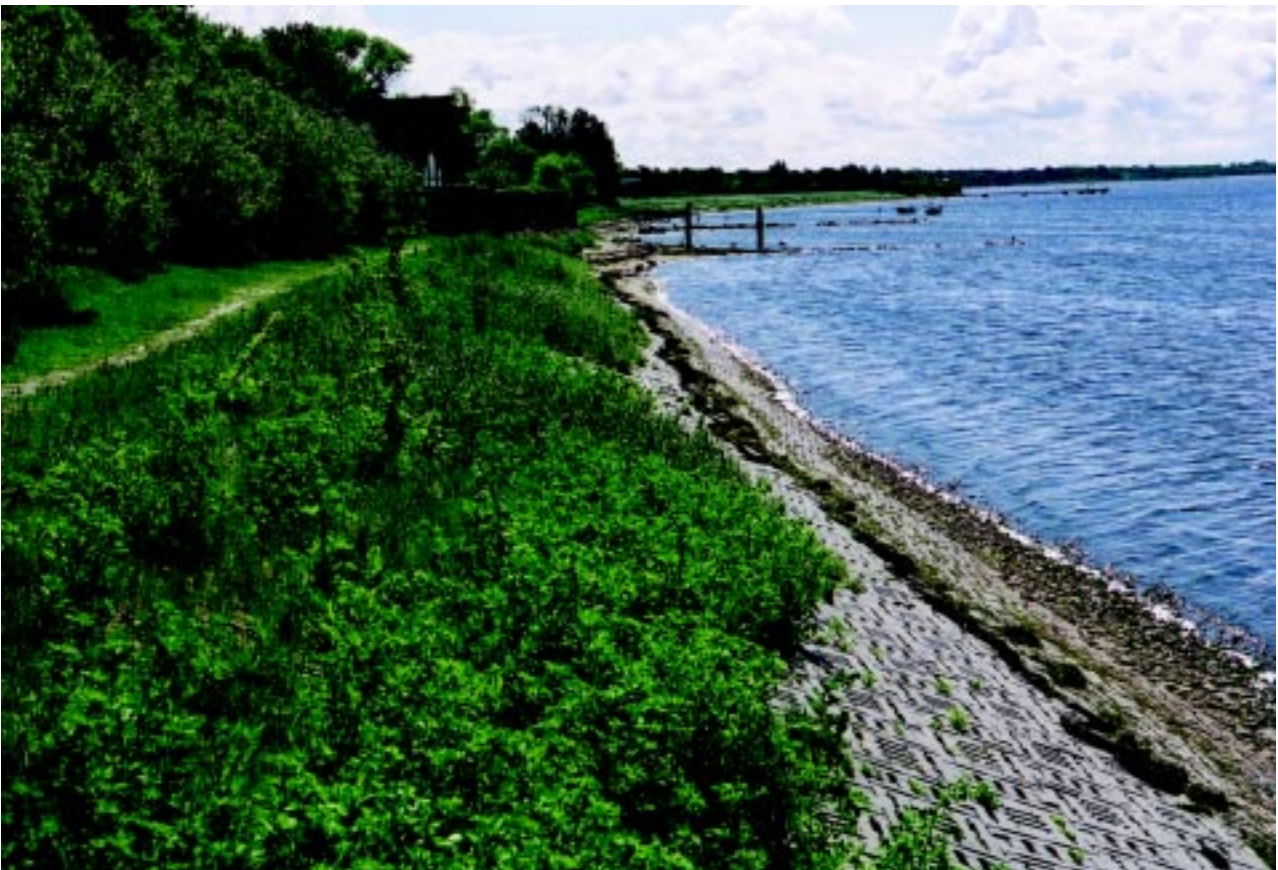
Samma plats 2001. Erosionsskydd av flexplattor i kombination med utfyllnad har säkrat kustavsnittet.
