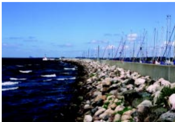
Erosionsskydd av kullersten.
