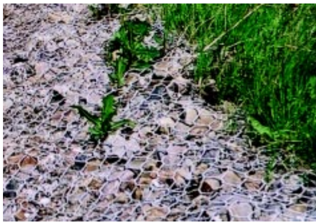
Fig. 22. Närbild på gabioner.
