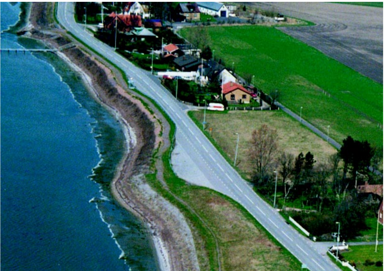
Samma plats 2001. Erosionsskydd av gabioner säkrar kustavsnittet.
