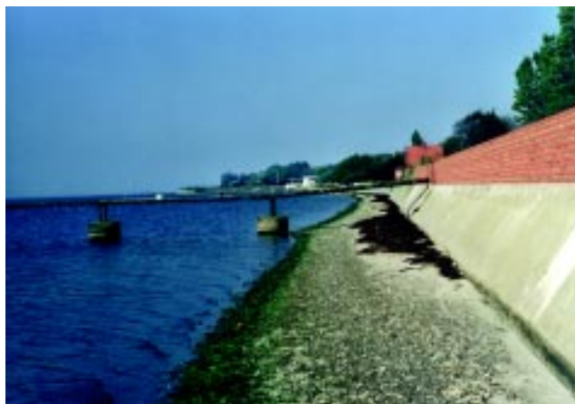
Fig. 14. Mur av betong och tegel.
